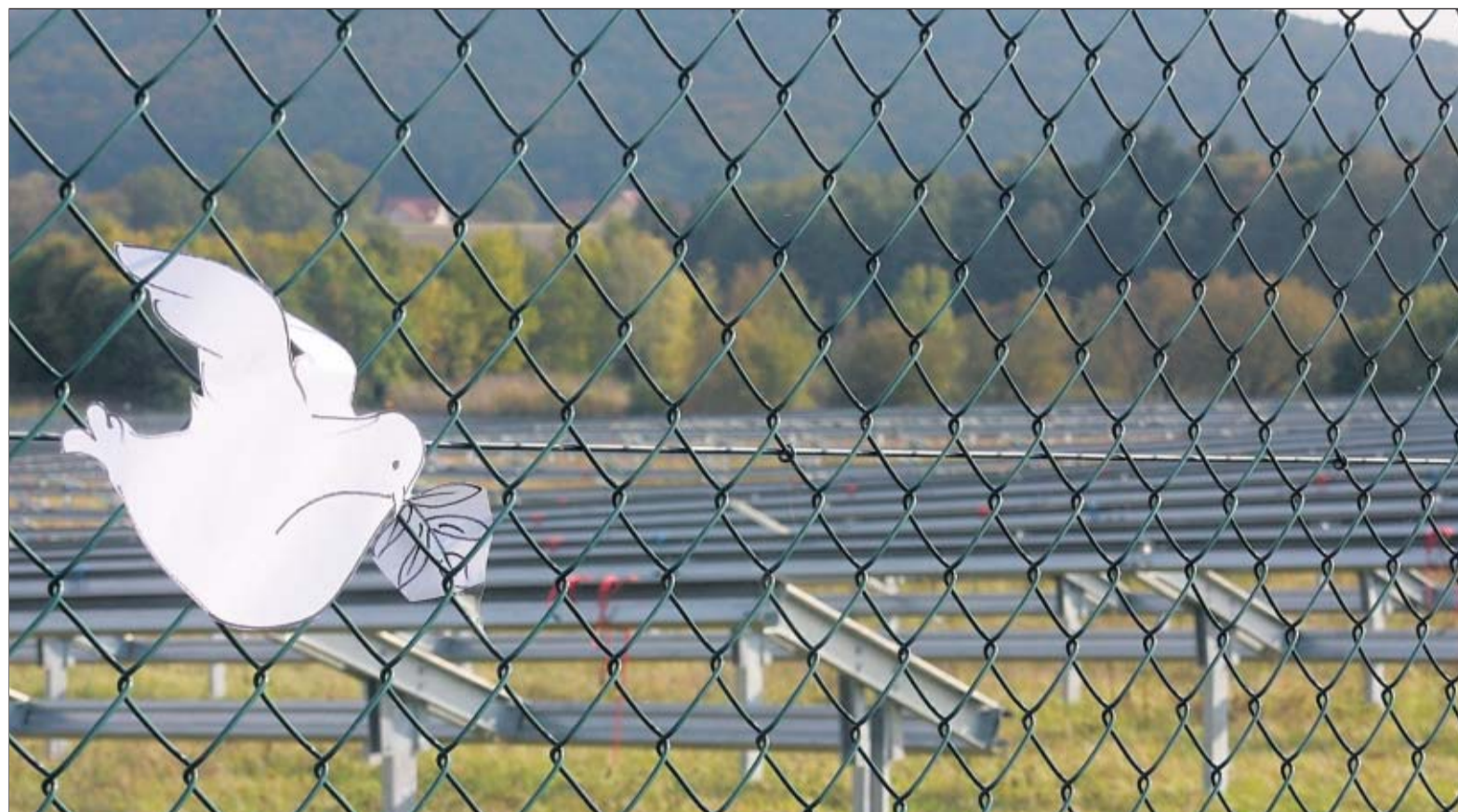
Eine Friedenstaube hängt am Maschendraht vor der Photovoltaikanlage am ehemaligen Bundeswehrgelände: Anscheinend ist sie nun auch gelandet. Foto: tnk
